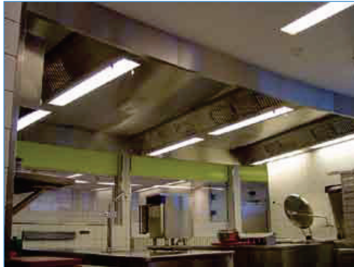
Abb. 2.29: Passgenaue Ausführung von Ablufthauben
