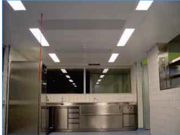
Abb. 2.32: Lüftungsdecke in einer großen Produktionsküche
